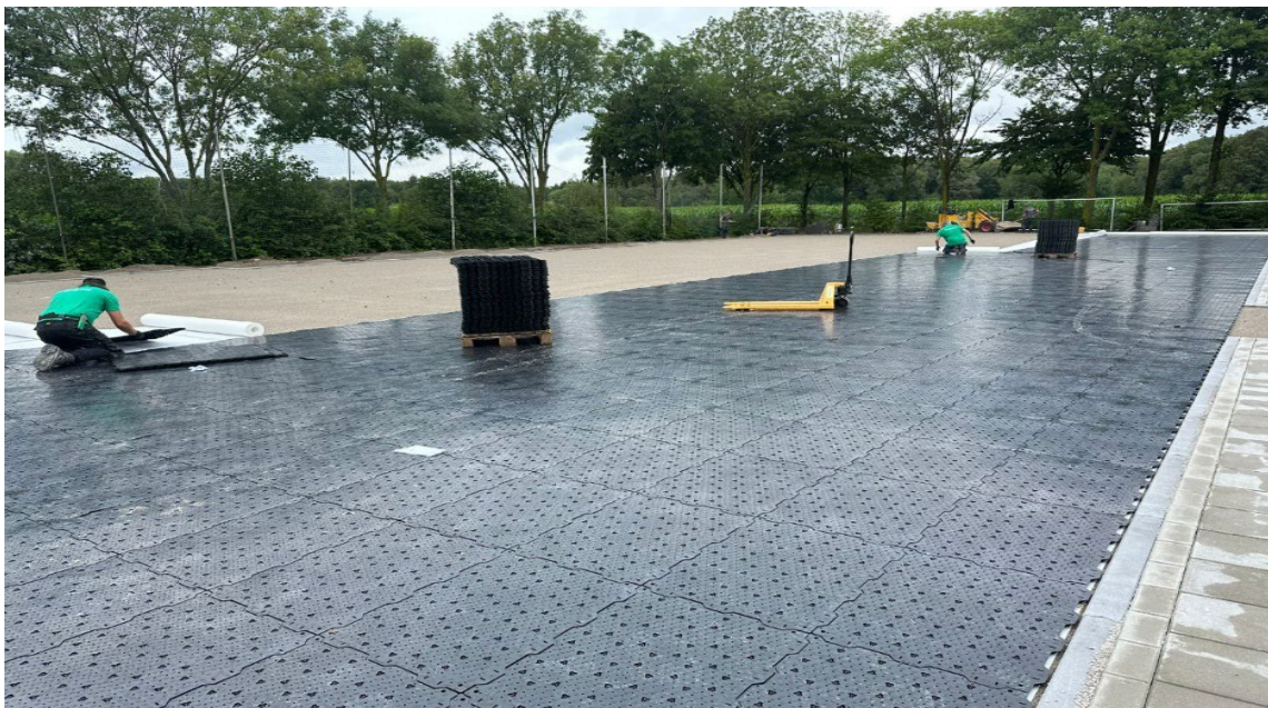
5 paveikslas - modulinio pagrindo plokščių montavimas
